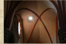
Il foro gnomonico della meridiana di Cassini si trova a un'altezza dal pavimento di 27 m e il suo diametro è di 27 mm. Nella foto i raggi del Sole che attraversano il foro nell'istante del mezzogiorno.
