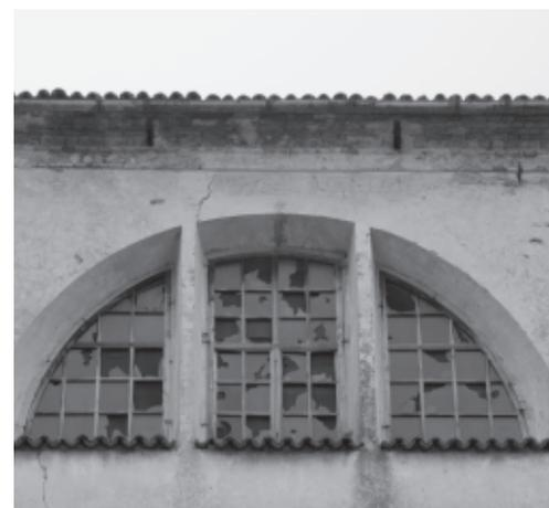
Degrado del cornicione e di una delle finestre.
