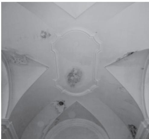
Il soffitto con alcune macchie dovute alle infiltrazioni d'acqua.
