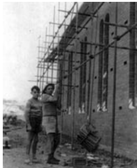
Paolo Taverna Turisan con Silvano Rigotti nell'inverno del 1958 alla costruzione della chiesa.
