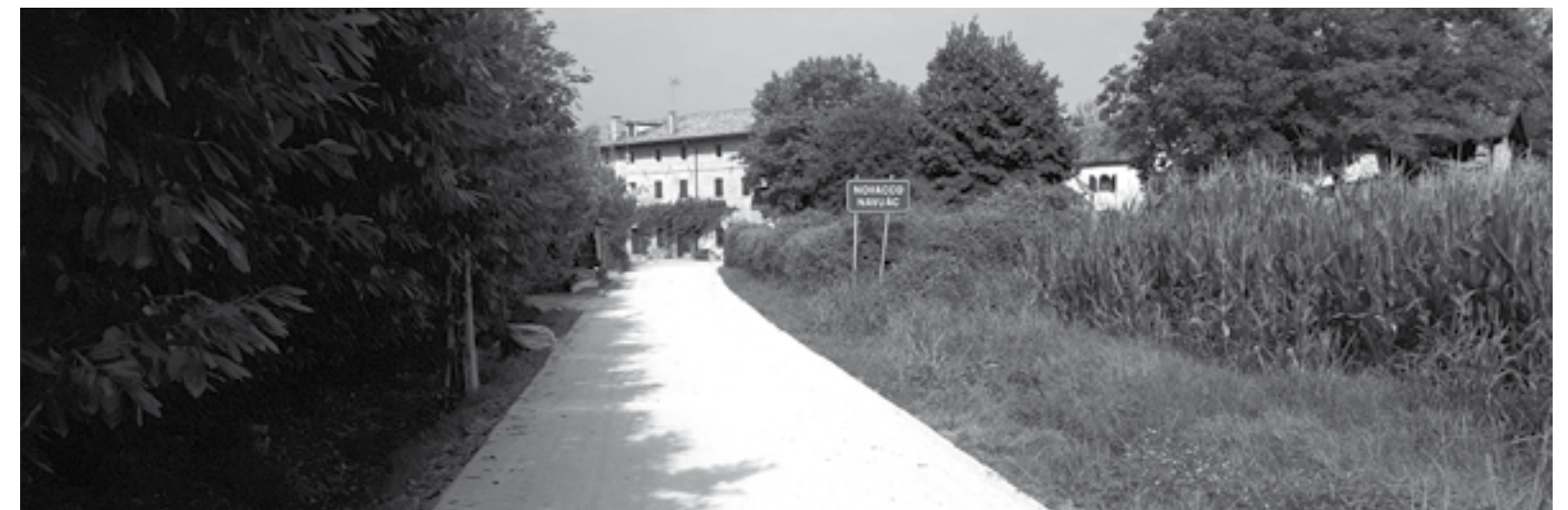
La nuova pavimentazione cementizia della strada del Novacco giungendo da Aiello.
