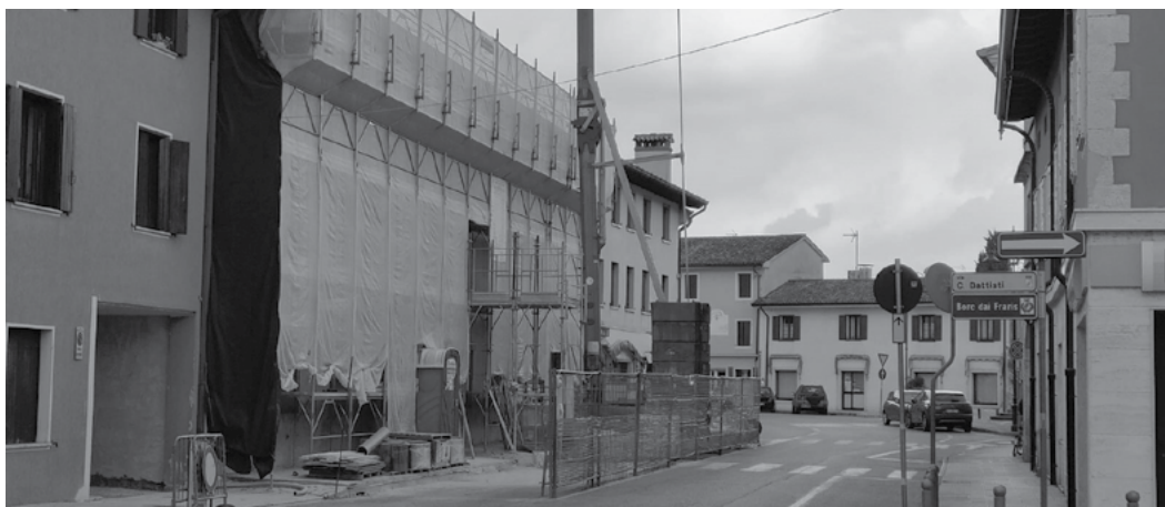
Il cantiere in corso all'ex Municipio di Aiello.
